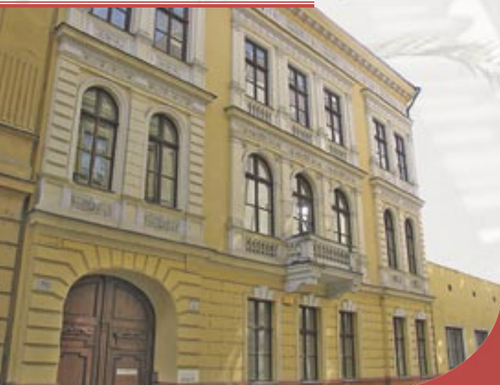
Podjavorinskej, kultúrna pamiatka z roku 1874 - 1887. Multifunkčný objekt.
